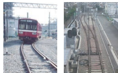
▲左:カント(傾斜)をつけた脱線復旧訓練線 右:教育訓練線
