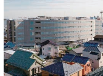
▲金沢文庫現業事務所 外観
