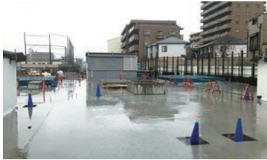
▲大師橋駅駅舎の基礎構築
