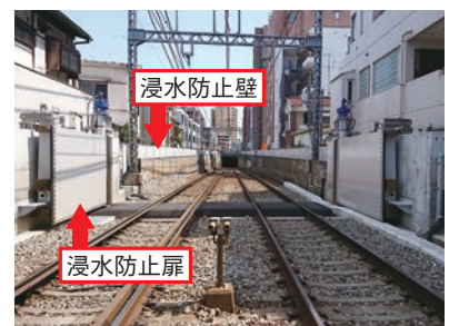
▲大鳥居駅トンネル入口(京急蒲田方)
